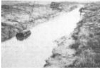
Abb. 3. Der große Schleppkübel des Meijerschen Gerätes beim Einsatz. Dieser Graben wurde von beiden Seiten geräumt, entsprechend der bestehenden Räumungspflicht.
