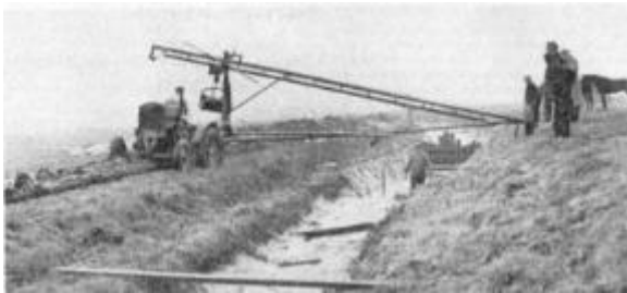
Abb. 1. Das Anhängerbückengerät System „Dertin“. im Graben eine Spundwand, davor eine Person zum Einsetzen des Kübels.
