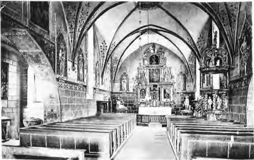
Alte Innenansicht der Kirche
